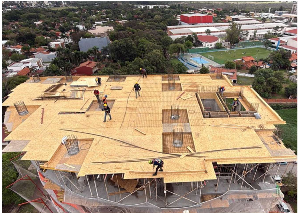
Elevación y revoque de mampostería – Encofrado de losa N9
