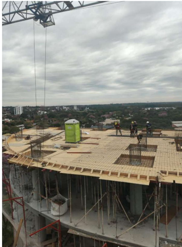
Encofrado, armado y cargamento losa N8
